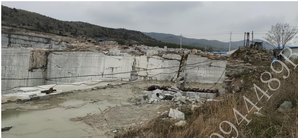
照片 3-4 废弃渣石乱堆乱放
