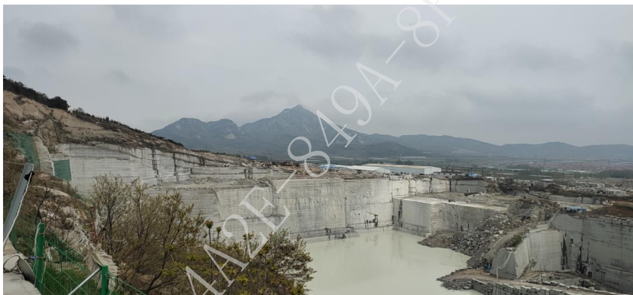
照片 3-3 治理区边坡岩石裸露，为岩质边坡
